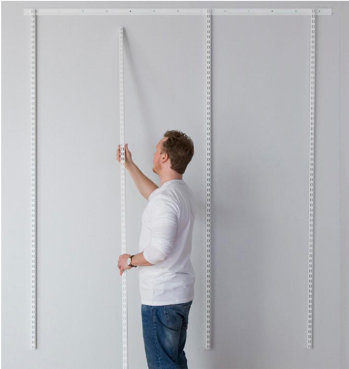
Haken Sie die Hängeschienen in die Tragleisten-Einkerbungen ein und ziehen Sie die Schienen in die gewünschte Position.
